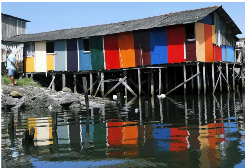
foto 1 - Cores no Dique
